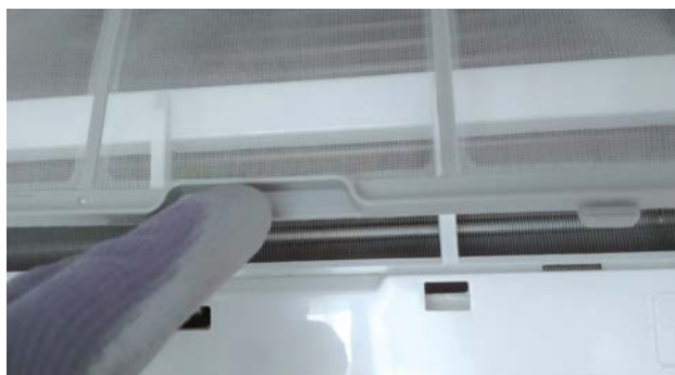
Démontage filtre de l'unité intérieure. © AFF.
