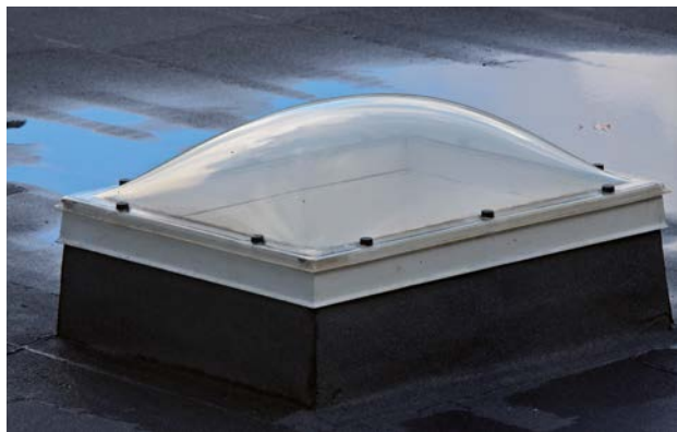
Élément contribuant aux apports thermiques externes. © AFF.
