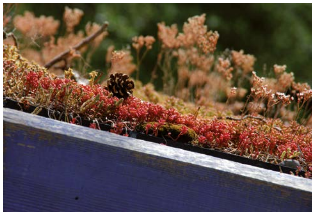
Toiture végétalisée. © AFF.
